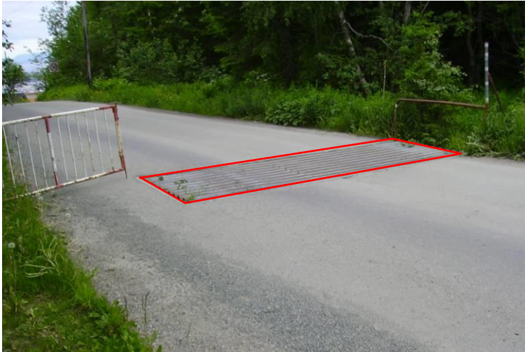
Figur 37: Eksempel på registrering av FeristAvgrensning (tegnet med rød strek).
