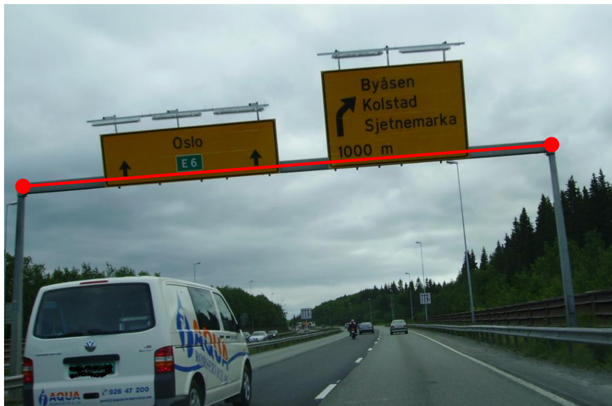
Figur 39: Eksempel på registrering av Skiltportal (rød strek). Det er ikke nødvendig å registrere stolpene som skiltportalen er festet i.
