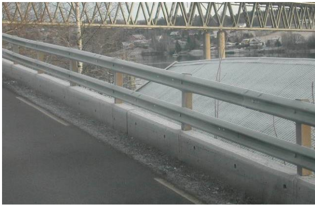
Til venstre er eksempel på topprekkverk på mur/kantdrage og til høyre er det eksempel på stabbesteiner
